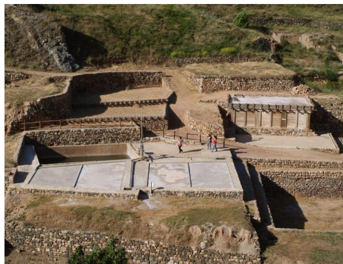
Figura 2: Vista parcial de las salinas de Poza de la Sal, un caso extraordinario de obtención de sal en el que se combina la evaporación solar y la minería por disolución
